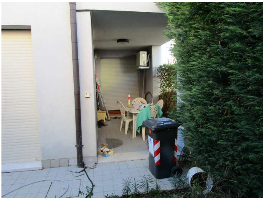
Foto 2 – Portico – ripresa fotografica dalla Corte esclusiva
