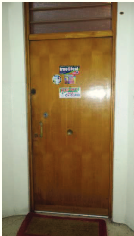
FOTO N. 3 Porta ingresso appartamento
