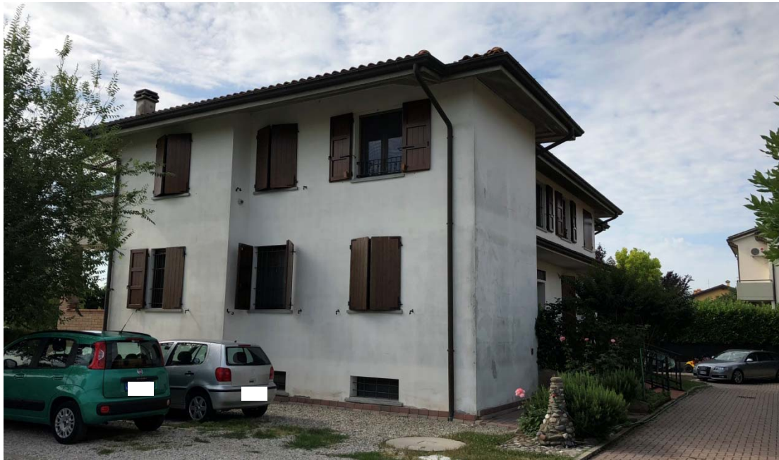
Prospetto del fabbricato
